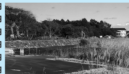
尾駮沼護岸整備工事
