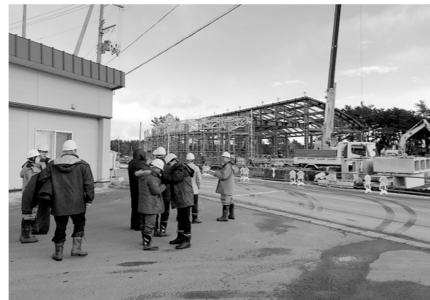
尾駿コミュニティセンターの現場視察の様子 [30年12月現在]
