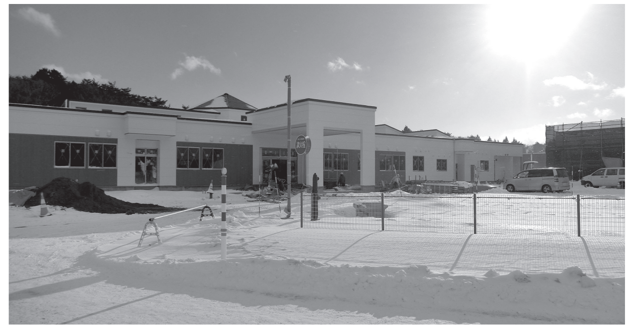
4月の開園に向け工事が着々と進む南こども園
