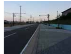
←尾駁小学校付近の道路沿い
