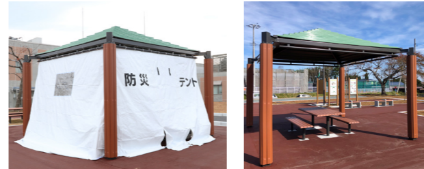
▶防災パーゴラ（東屋） 緊急時は『簡易な災害対策施設』として機能する
