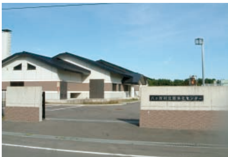
北部浄化センター
