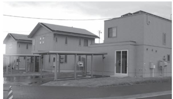
震災でも停電にならなかった スマート・グリットハウス
