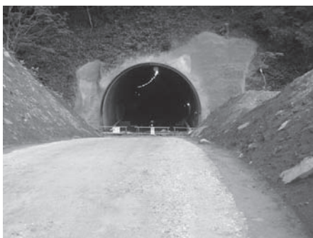
来春開通予定の国道 338 号泊・白糠間
