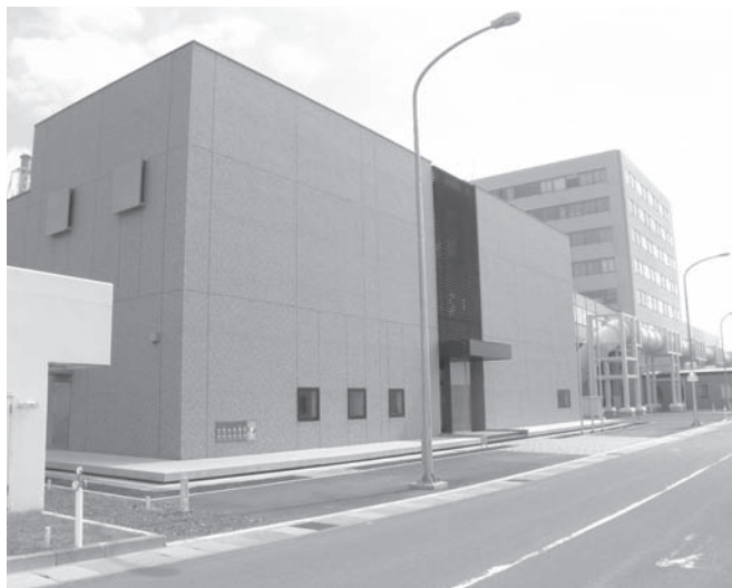
本年11月運用開始予定の緊急時対策所
