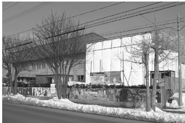
増改修工事中の千歳平地区公民館
