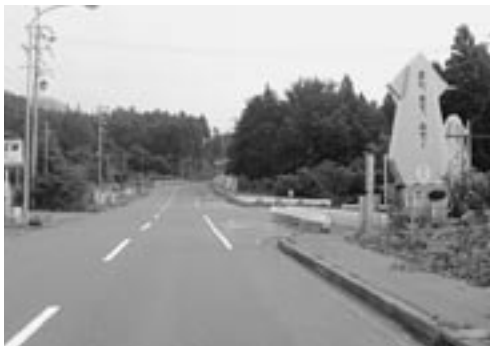
泊入口付近の状況
