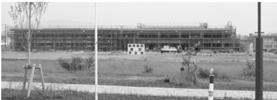
建設工事中の尾駮小学校
