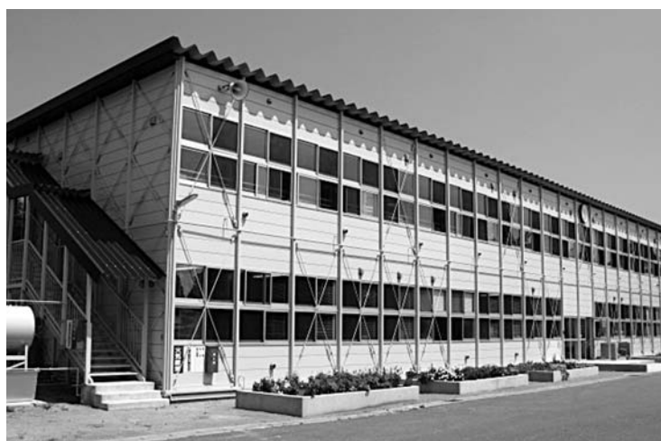
耐震不足のためプレハブ校舎に立て替えられた倉内小学校
