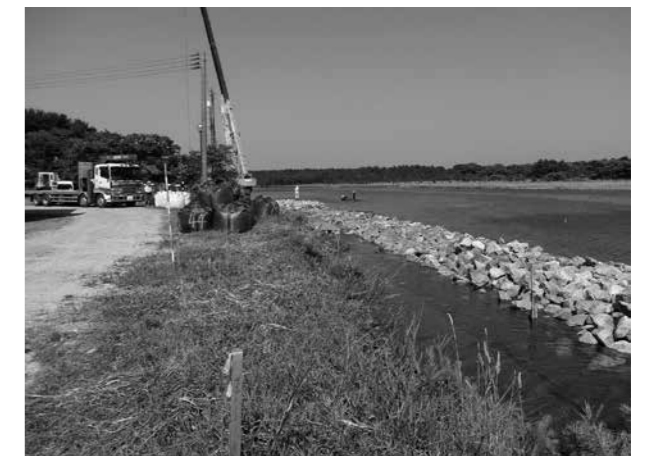
尾駁沼護岸整備工事の様子 （市原クラブ付近より撮影）
