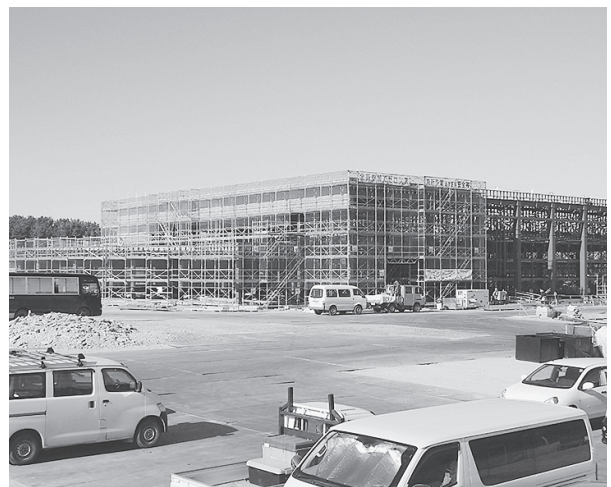
29年度の開設を目指し建設が進む屋内温水プール
