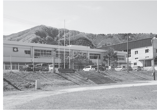
老朽化が進み整備が検討されている泊中学校
