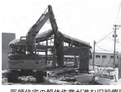
医師住宅の解体作業が進む旧診療所敷地内
