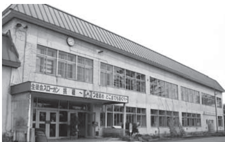
老朽化が進む千歳中学校
