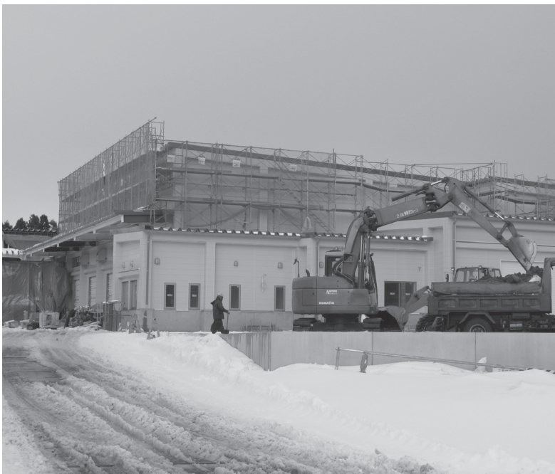
本年4月併用開始予定の長芋洗浄選別貯蔵施設の工事の様子
