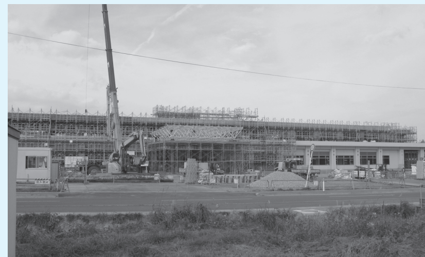
建設中の(仮称)総合医療福祉施設(25年11月6日撮影)
