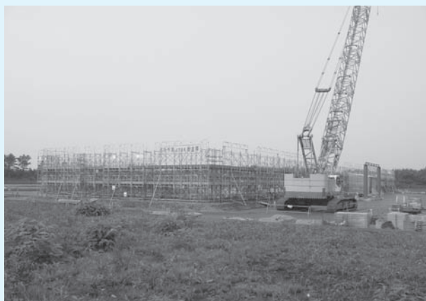
(仮称) 総合医療福祉施設の7月末現在の工事状況
