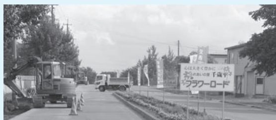
工事中の千歳平1号・2号幹線
