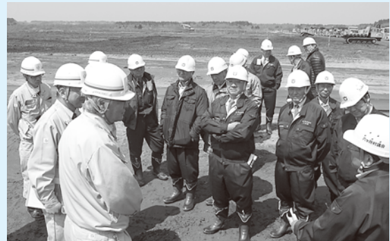
浚渫土の埋設状況
