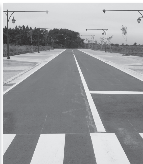
昨年工事した緑道
