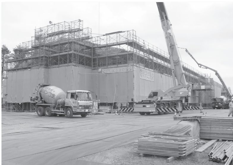
平成25年4月開校に向け工事が進められている倉内・平沼小学校統合小学校
