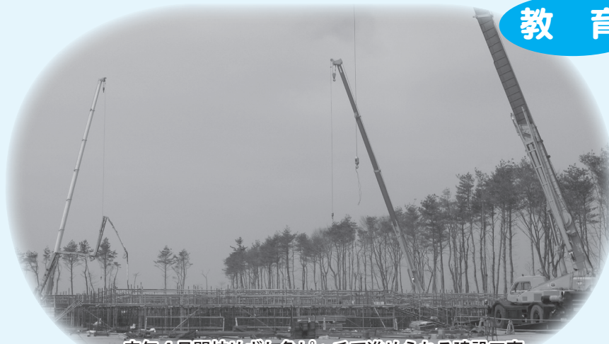
来年4月開校めざし急ピッチで進められる建設工事
