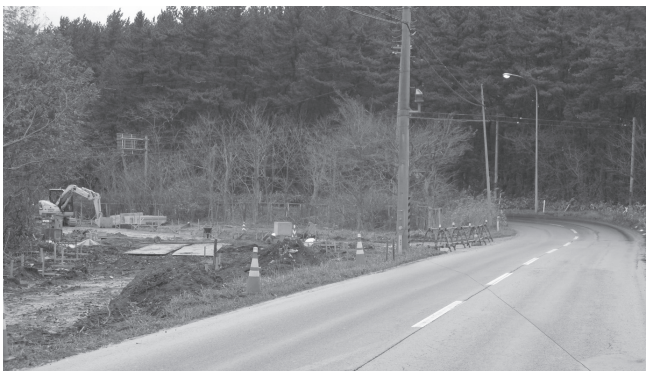
改良工事が進む国道338号旧鷹架小学校前
