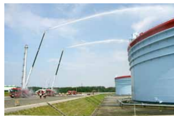
タンク火災を想定して行われた消火訓練
