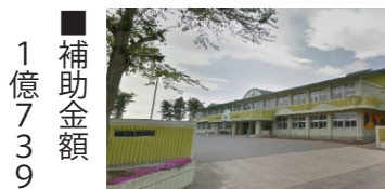
▼校舎各教室にエアコン・全熱交換機を設置 ▼講堂既存暖房機の更新
