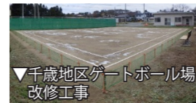
▼千歳地区ゲートボール場改修工事
