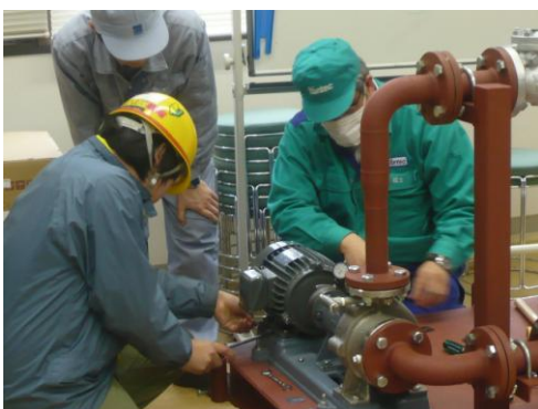
横型ポンプ保修訓練
