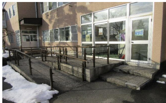
分庁舎玄関のスロープ
