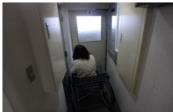
本庁舎トイレ入口（通路が狭い）
