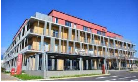
ルーバーによる日射遮蔽 (浦安市庁舎)
