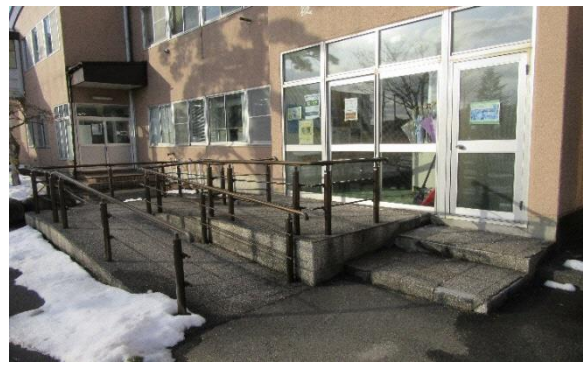
分庁舎玄関のスロープ
