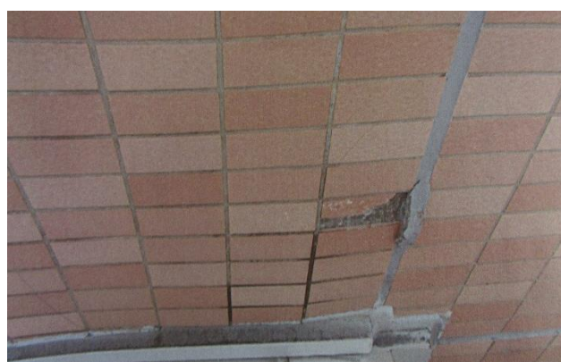
雨漏りの原因
