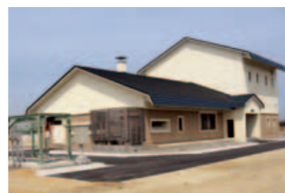
南部浄化センター
