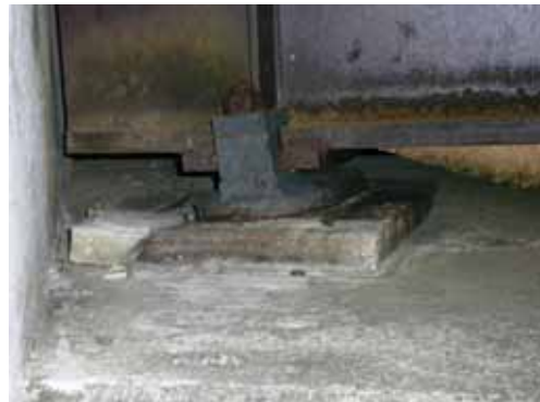
写真2 - 支承・沓座モルタル(湯ノ沢橋)
