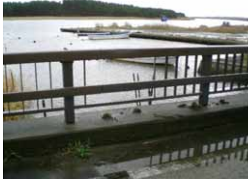
写真 5 - 防護柵(市柳橋)
