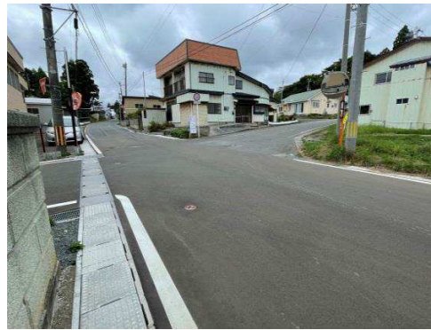
④村道尾駁家ノ前1号線 光明寺付近
