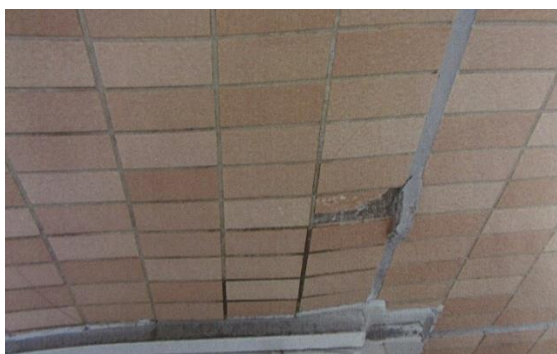
雨漏りの原因
