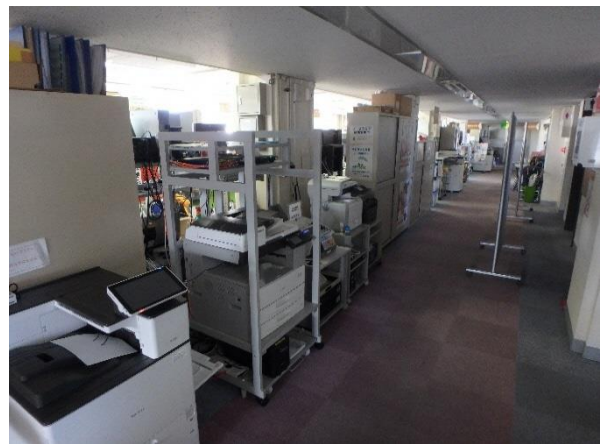
廊下に設置されている防災関連機器
