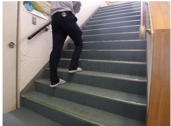
分庁舎階段（踏面が狭く登りづらい）
