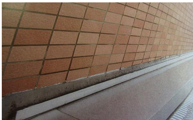
雨漏りの原因
