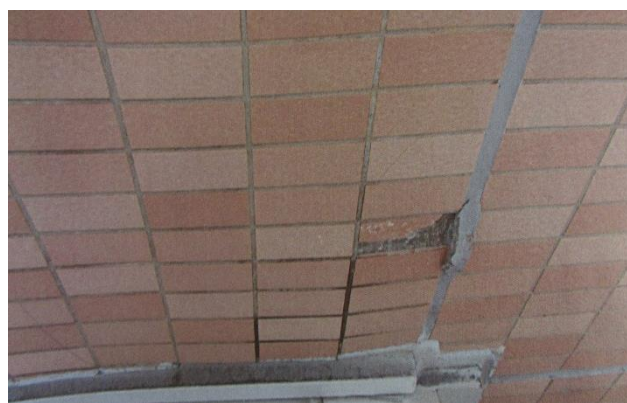
雨漏りの原因
