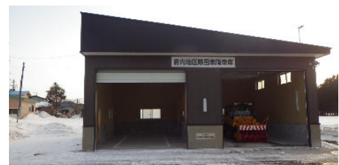
整備した倉内地区除雪車両車庫
